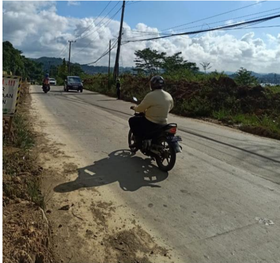
Gambar 2. Kondisi Jalan di Teluk Bajau
