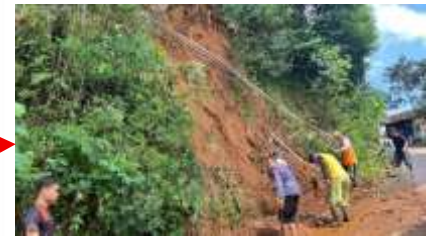
Sumber: Dokumentasi Gambar 1. Lokasi Longsor
